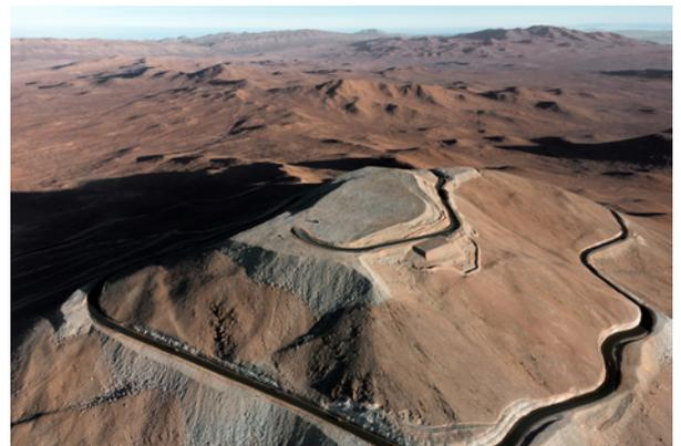
Um die ebene Fläche von 300 x 150 Metern auf dem Cerro Armazones zu erstellen, auf der das E-ELT errichtet wird, mussten insgesamt 220 000 Kubikmeter Gestein abgetragen werden. Inzwischen sind das Plateau und die Zufahrtsstraße fertig, wie diese Luftaufnahme aus dem November 2015 zeigt. (Bild: ESO/G. Hüdepohl, atacamaphoto.com)
