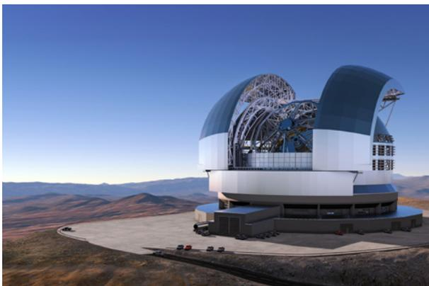
Das European Extremely Large Telescope, kurz E-ELT, wird das größte jemals gebaute optische Teleskop. Sein Hauptspiegel hat einen Durchmesser von 39 Metern und besteht aus 798 einzelnen Spiegeln. Im Jahr 2024 soll das Teleskop fertig sein und dann in Realität so gigantisch erscheinen wie in dieser computergenerierten Darstellung. (Bild: ESO/L. Calçada/ACE Consortium)
